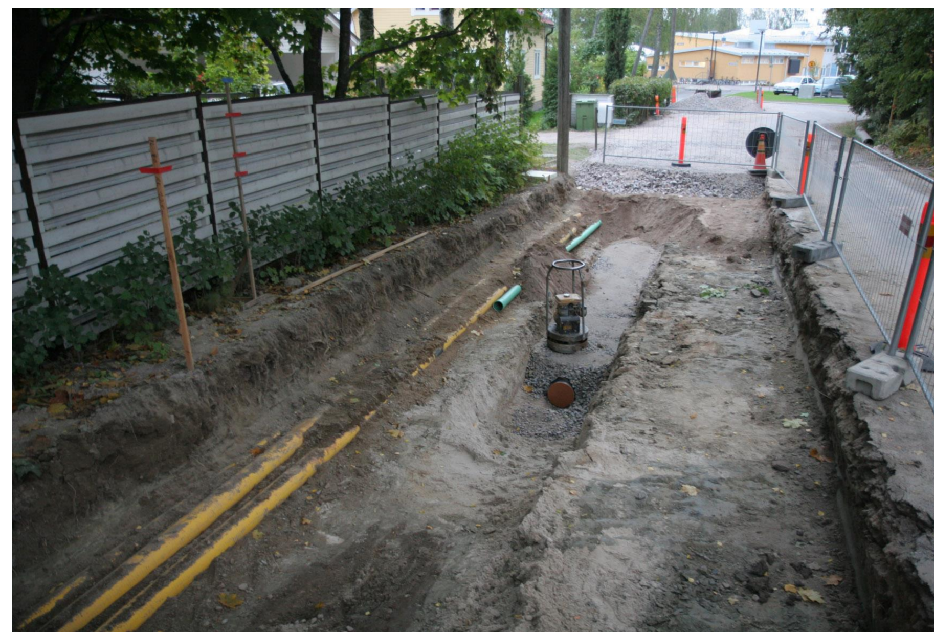
Friisilä sai asemakaavan vuonna 1999. Siitä lähtien kaupunki rakensi katuja kaavan mukaiseen kuntoon. Pessimistit ennustivat, että siihen meni 20 vuotta. Tässä rakennetaan Holmanmäentietä syyskuussa 2006. Näkyvissä olevat putket ovat sähkö- ja tietoliikenneputkia sekä uutuutena ojan pohjalla sadevesiviemäri. Jokseenkin 20 vuotta myöhemmin tiet oli rakennettu. Kuva Antti Pietiläinen
