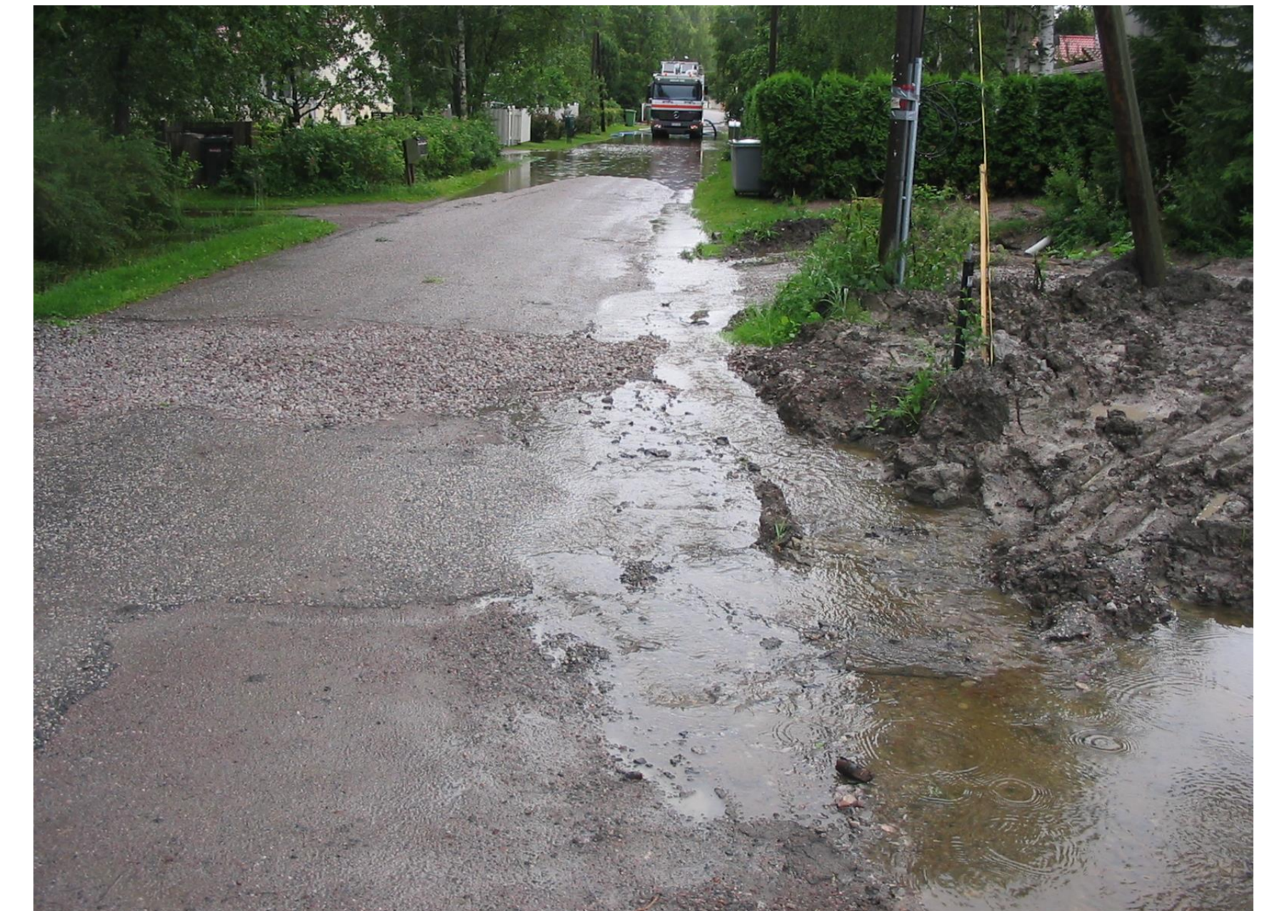
Osa asukkaista oli täyttänyt katuojan tonttinsa kohdalla ja asentanut sinne putken niin ja näin. Tuloksena oli tulvia alavilla alueilla. Nuolitieltä pumpataan vettä sadekesänä 2004. Kuva Antti Pietiläinen
