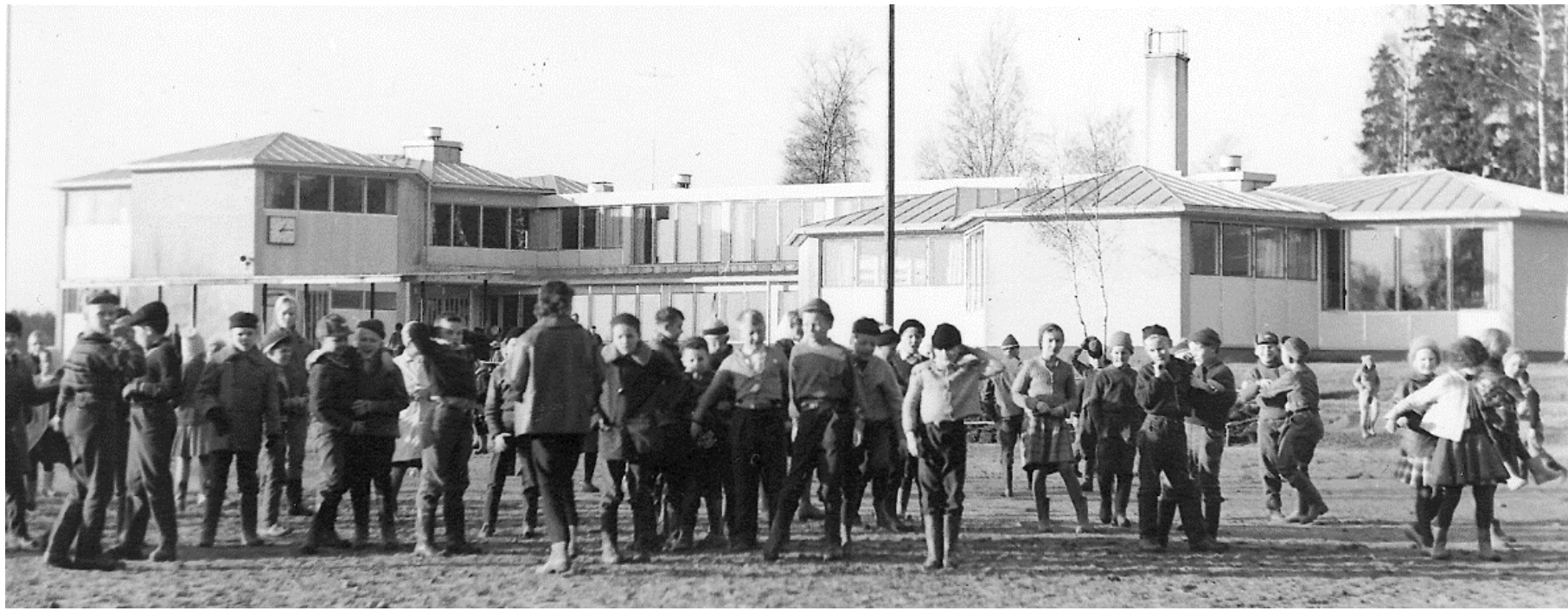
Kylän oma, vastavalmistunut Jorma Järven suunnittelema Vapaaniemen koulu lukuvuonna 1959-1960. Jorma Järven käsiälää on myös Tapiolan koulu, jossa sielläkin on mehiläiskennon muotoisia luokkahuoneita.
