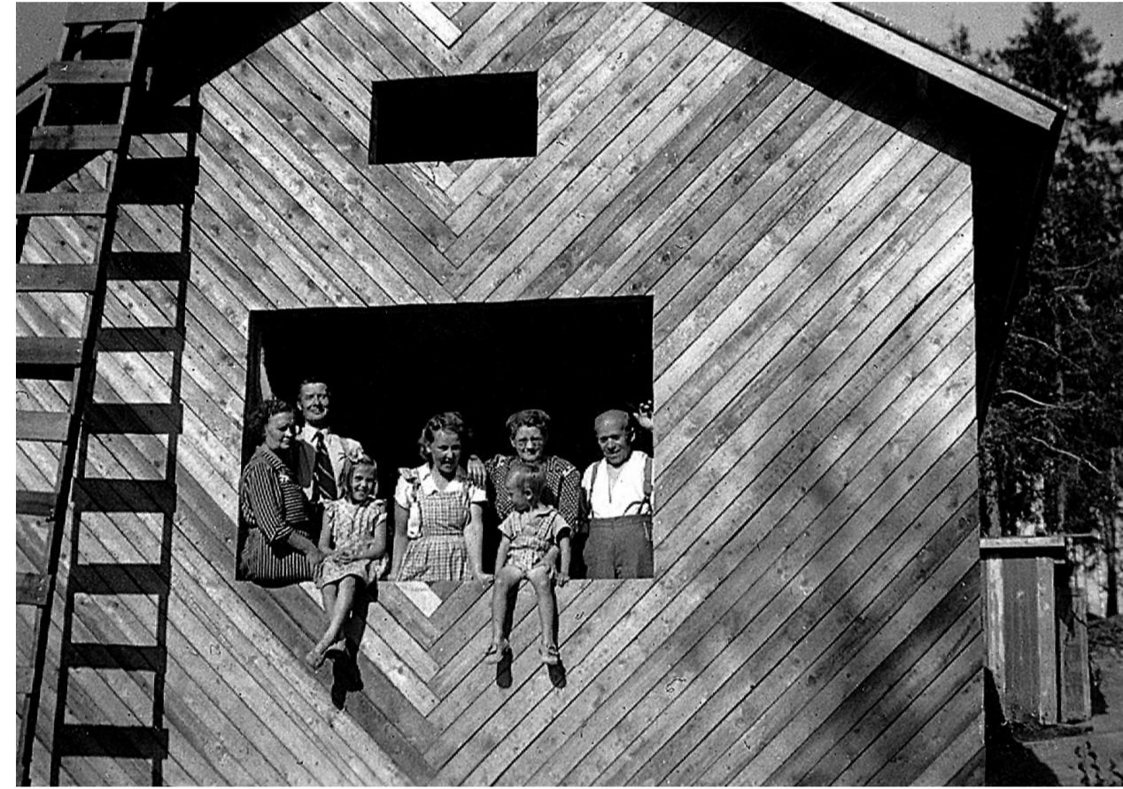
Grundströmin perhe keskeneräisen kotinsa ikkuna-aukossa. Tontti sijaitsee Frisansintien (nyk. Friisiläntie) ja Nuolientien kulmassa. Vinolaudoituksella varmistettiin rakennuksen jäykkyys, ulkolauditus saatettiin tehdä joko pysty- tai vaakasuoraan.
