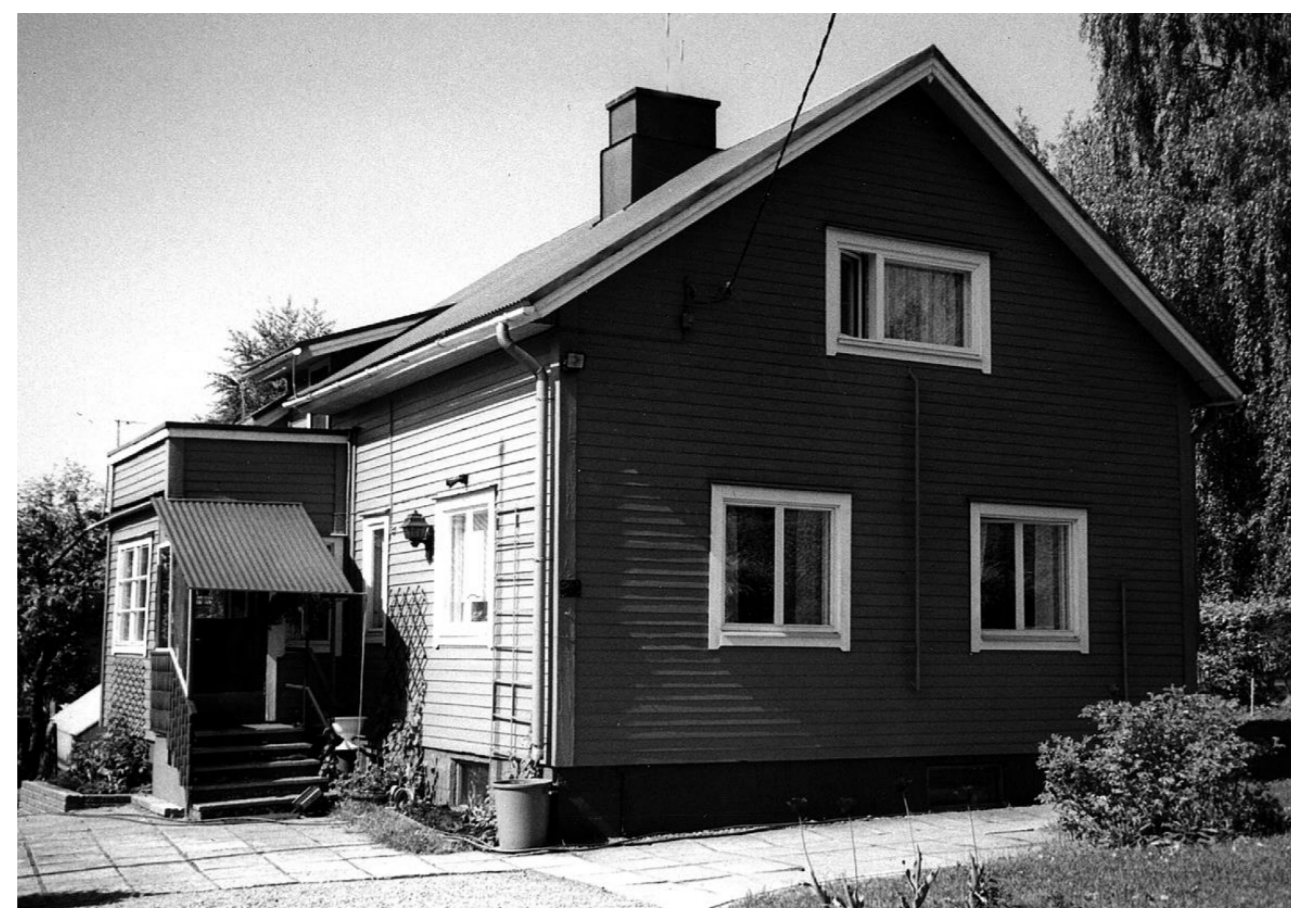
Bengt Lindhin lähes kokonaan omin käsin rakentama talo Friisiläntielle valmistui vuonna 1949. Vuonna 2010 Lindhit muuttivat Palvelutalo Hopeakuuhun ja talo purettiin uudisrakennuksen tieltä.
