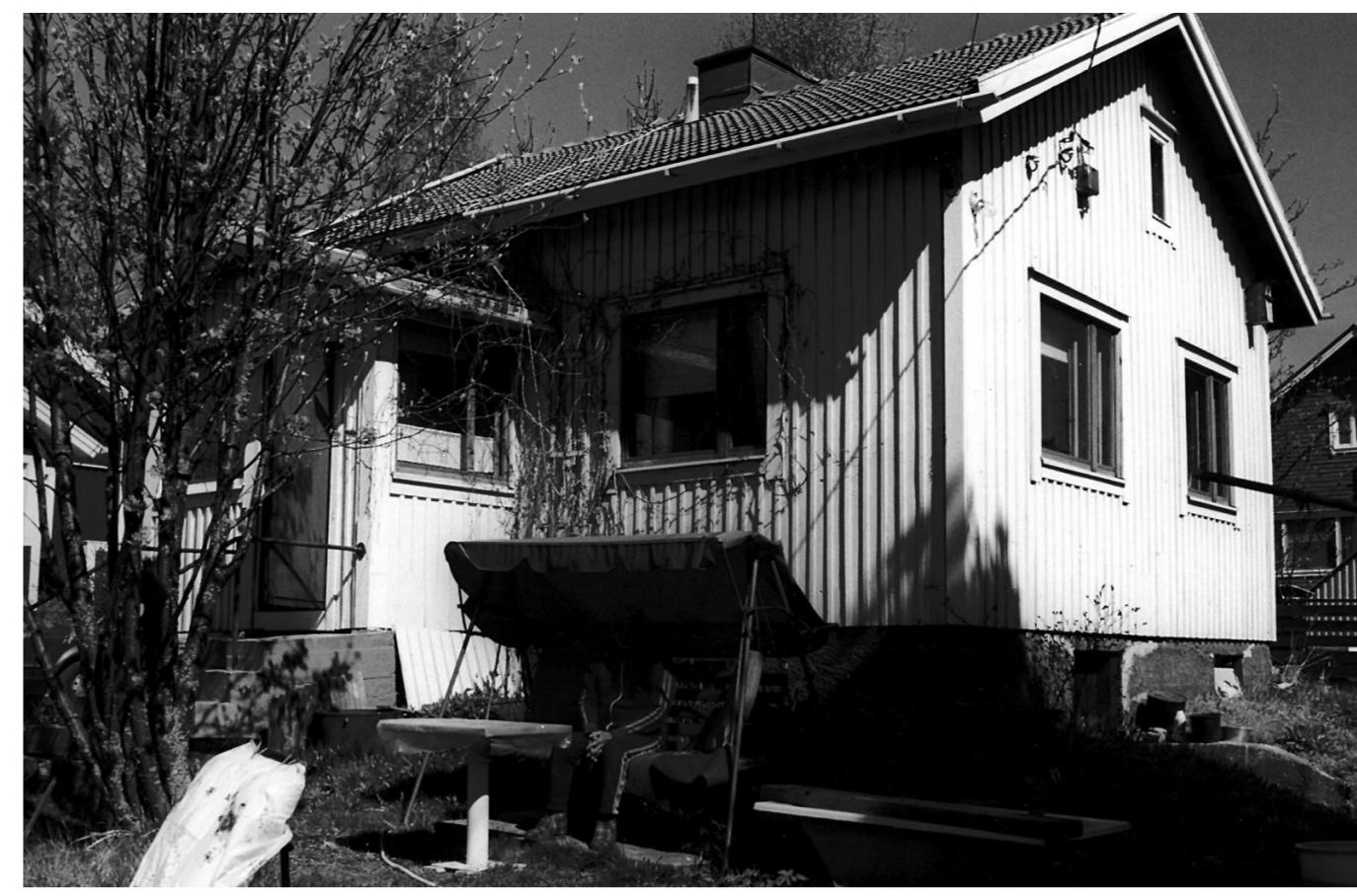
Kaarlo Alho rakensi talonsa ilman ainuttakaan palkattua ammattimiestä. Rakennus valmistui vuonna 1949.
